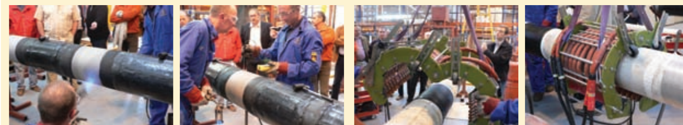
Epoxy alapozást megelőző felület-előkészítés – hevítés – hőmérséklet-mérés
