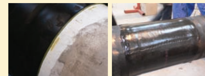
A felhordott késztermék utólag felhegesztett zárócsikk alkalmazásával
