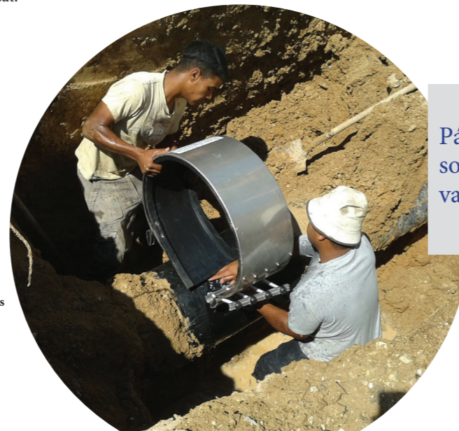
REPAMAX mint csőjavítás
