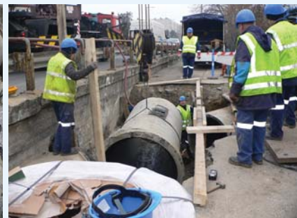
A sérült csőszakasz kiemelése sem egyszerű feladat a helyszűke miatt
