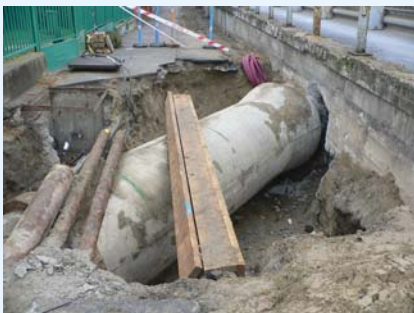
A feltárt munkaterület támfallal és földkábelekkel
