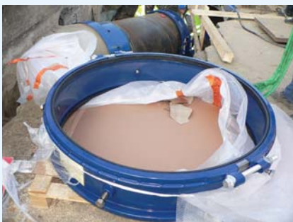
Az SB-acél átmeneti idomok felszerelve, egy HYMAX már a csővégen, egy még raklapon
