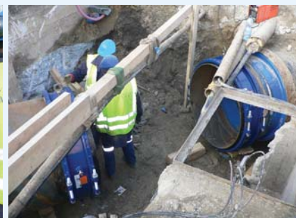
Mindkét HYMAX a helyén, a betoldandó acélcső fogadására készen
