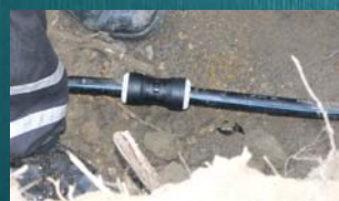
Az eredeti vízellátás visszaállítása egy PLASSON Ser.1 gyorscsatlakozó egyenes összekötő felszerelésével
