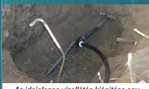
Az ideiglenes vízellátás kiépítése egy tűzcsap segítségével, a vezeték átvágásával és egy PLASSON Ser.1 gyorscsatlakozó könyökidom beépítésével
