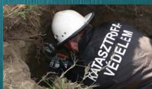
KRAUSZ HYDROFLEX kötő-javítóidom felszerelése
