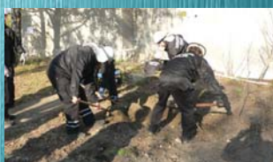
A jelenlegi ellátó vezeték feltárása az ideiglenes vízellátás kiépítése céljából
