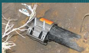
KRAUSZ HYDROFLEX kötő-javítóidom felszerelése
