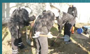
A csőtörés pontos helyének feltárása
